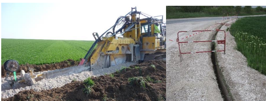
Figure 3. Exemple de tranchée réalisée (Source : TotalEnergies)
